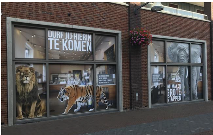
Campagne gevel-bestickering tijdens verbouwing.
